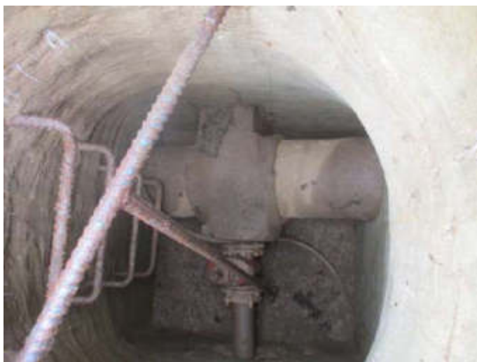
Registro tubería de agua potable. FD 350 mm. Oeste del Sector.
